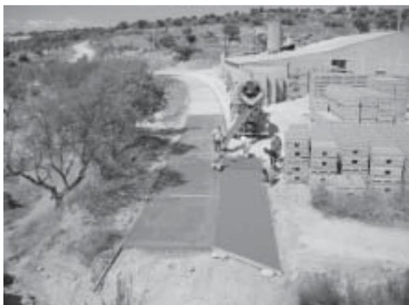
*Asimismo se ha acondicionado el acceso de Val de la Reguera mediante el hormigonado del correspondiente vado. En esta última obra, la Junta de caminos ha coparticipado mediante la ampliación de la anchura a su cargo y la mejora del desagüe del tunel.*
