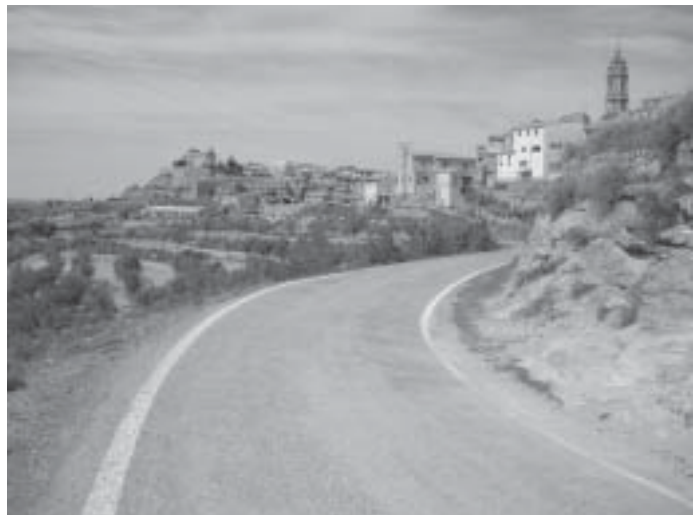
En el Convenio se prevé realizar el colector de aguas residuales de la margen izquierda de Valdealgorfa.
